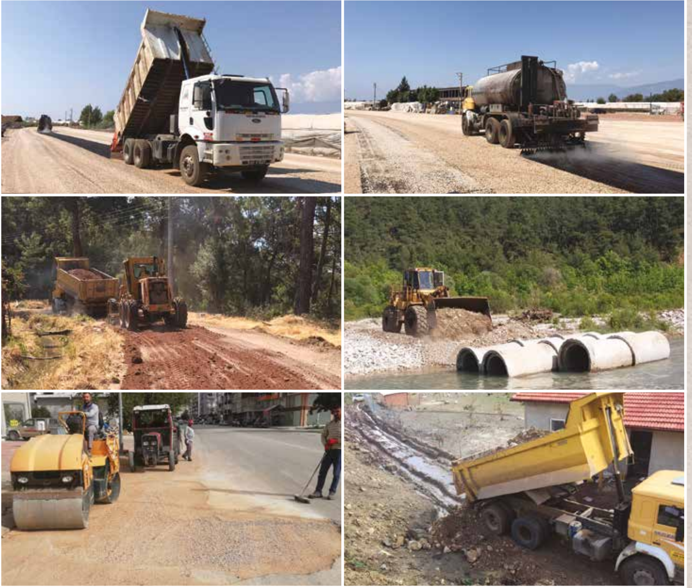
1-5) YAĞMUR SUYU DEŞARJ ŞEBEKESİ VE TESİSLERİ YAPILDI TESİSLERDE KULLANILAN BETON BÜZ/KORUGE BORU
